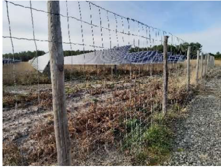
Illustration d'une clôture avec poteau en bois
